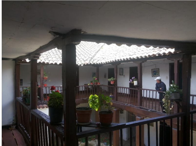
Fig. 1. Estudio de caso. Edificación del siglo XIX en Colombia
