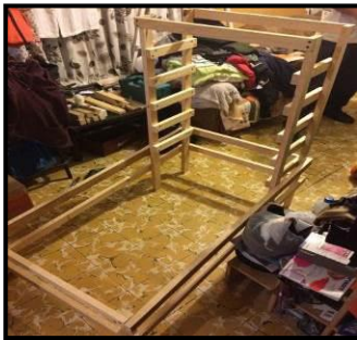
Ilustración 2: Construcción del deshidratador solar.
